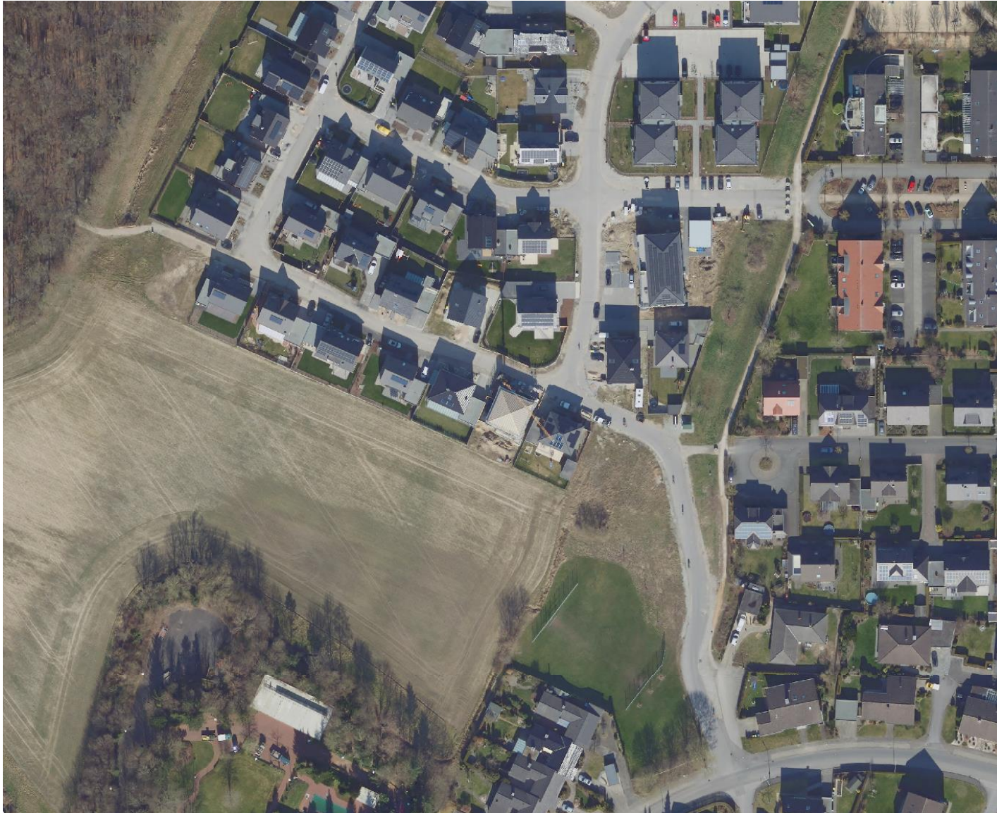
Luftbild – südlicher Abschnitt
